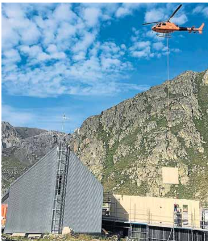
Un helicóptero deja material para la obra del segundo edificio.
